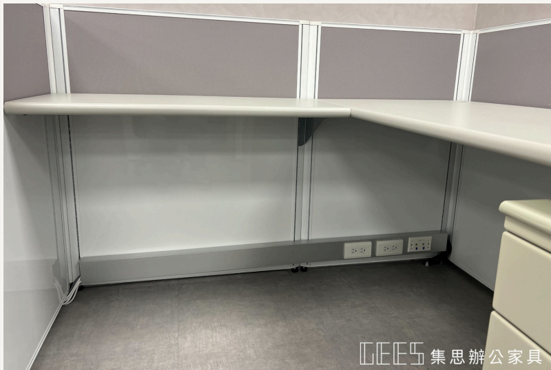
工作位實拍 | 屏風下方線槽與插座配置
